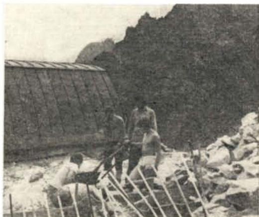
Rozbudowa „Terinki”: taternicy przy pracach ziemnych, a właściwie skalnych — lipiec 1979.
